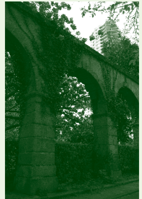
Arcades installées Square Guy Houist / Bourg L'Évêque
